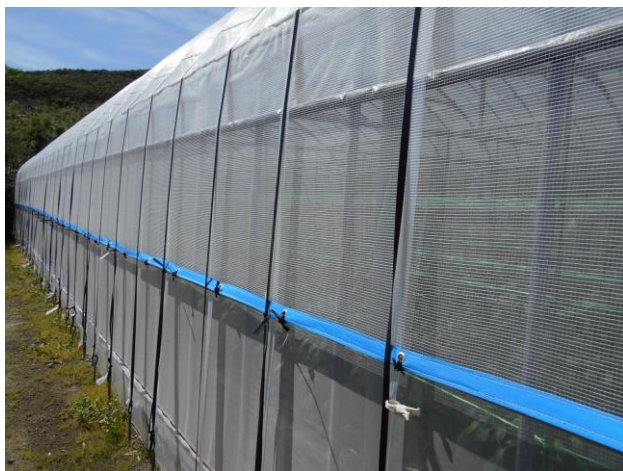
▲修復が完了した耐風ハウス
