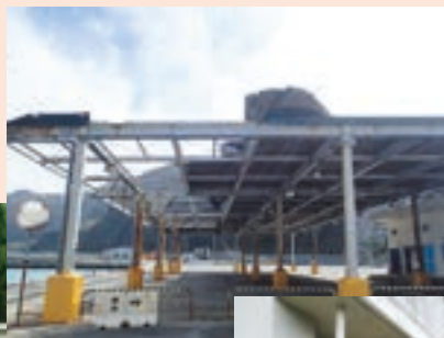
◀屋根が剥がれた 漁業用日除け施設
