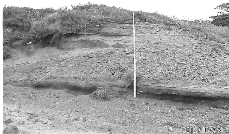
写真2 攻撃斜面側に露出した地層（3m長の標尺部分） 矢印は写真3の撮影個所を示す
