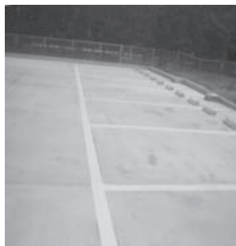
▲整備後の駐車場
