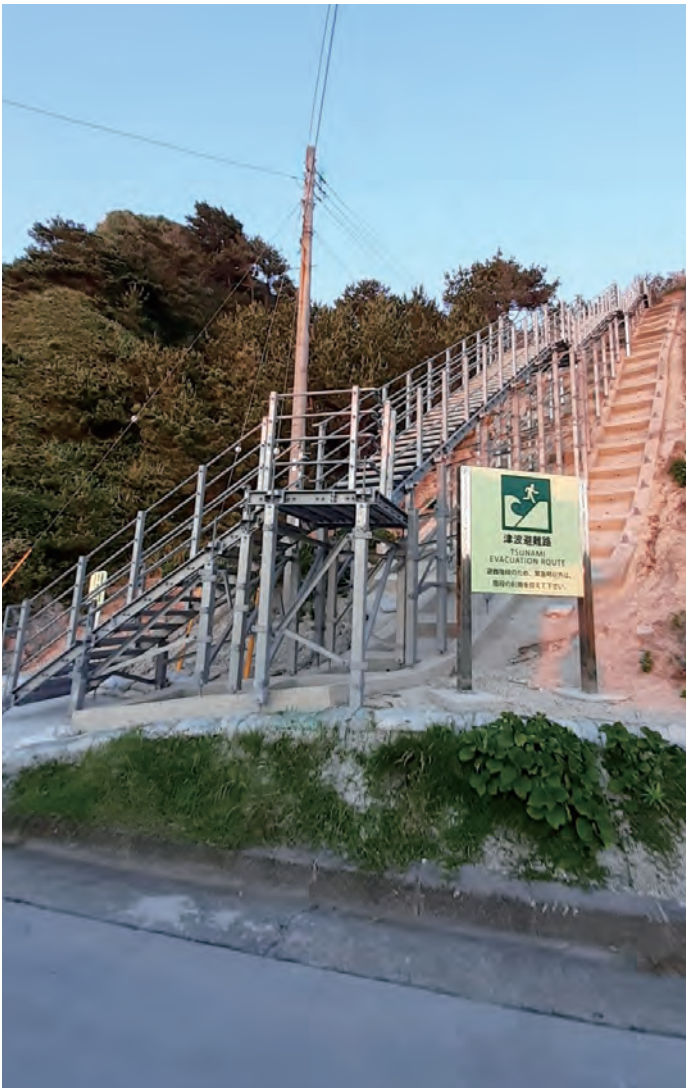
▲湯の浜露天温泉前の避難階段。傾斜は急であり、避難時のみ使用可能
