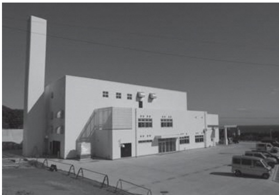
完成した真新しい焼却場。
