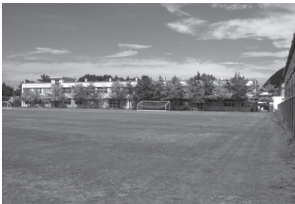
廃校となった旧新島中学校の全景。
